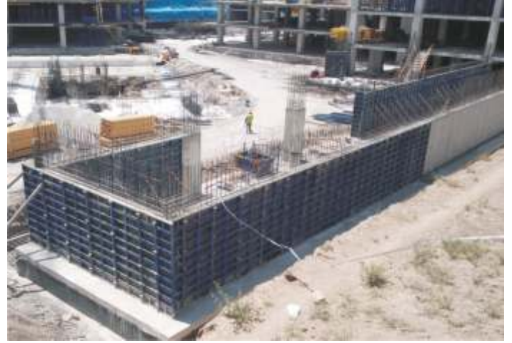
Mevcut kolonda kullanılan MO-KAI panellerin yan yana birleşmesiyle istinat perdesi veya bina perdesi kurulabilir.
