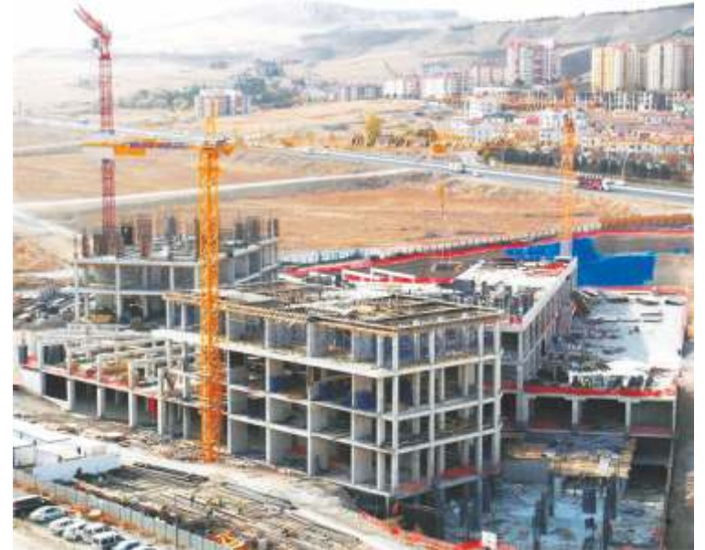
Ankara-Eskişehir Karayolu üzerinde yükselen West Gate Residence projesi Ankara'nın en büyük rezidans projesi olma özelliğine sahiptir. Çok değişik kolon kesitlerine sahip olan bu projede firma üretmiş olduğumuz plywood yüzeyli kalıp olan MO-KAI kalıbı seçmiştir. Kalıp altı iskele olarak "H125*175" tip masa tip iskele kullanılmıştır.
